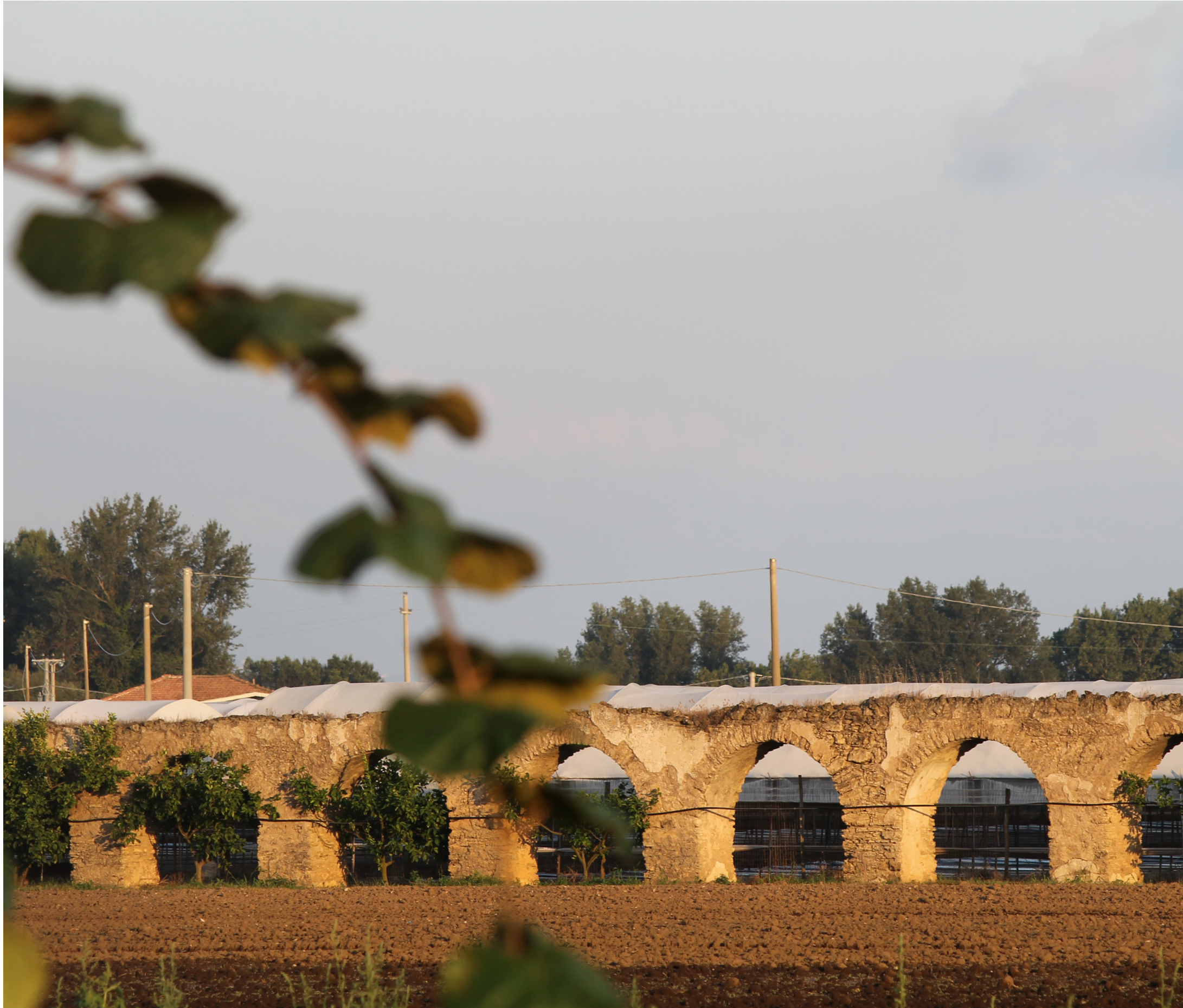
14. Acquedotto nella piana del Sele (foto di M. Scala)
