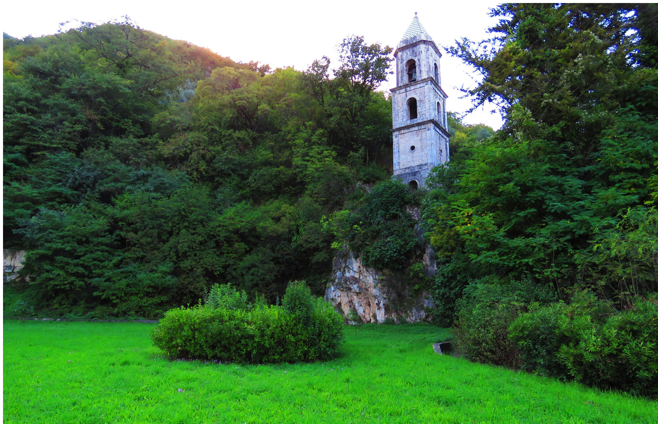
12. Caposele, campanile delle Sorgenti (foto di G. Vitolo)
