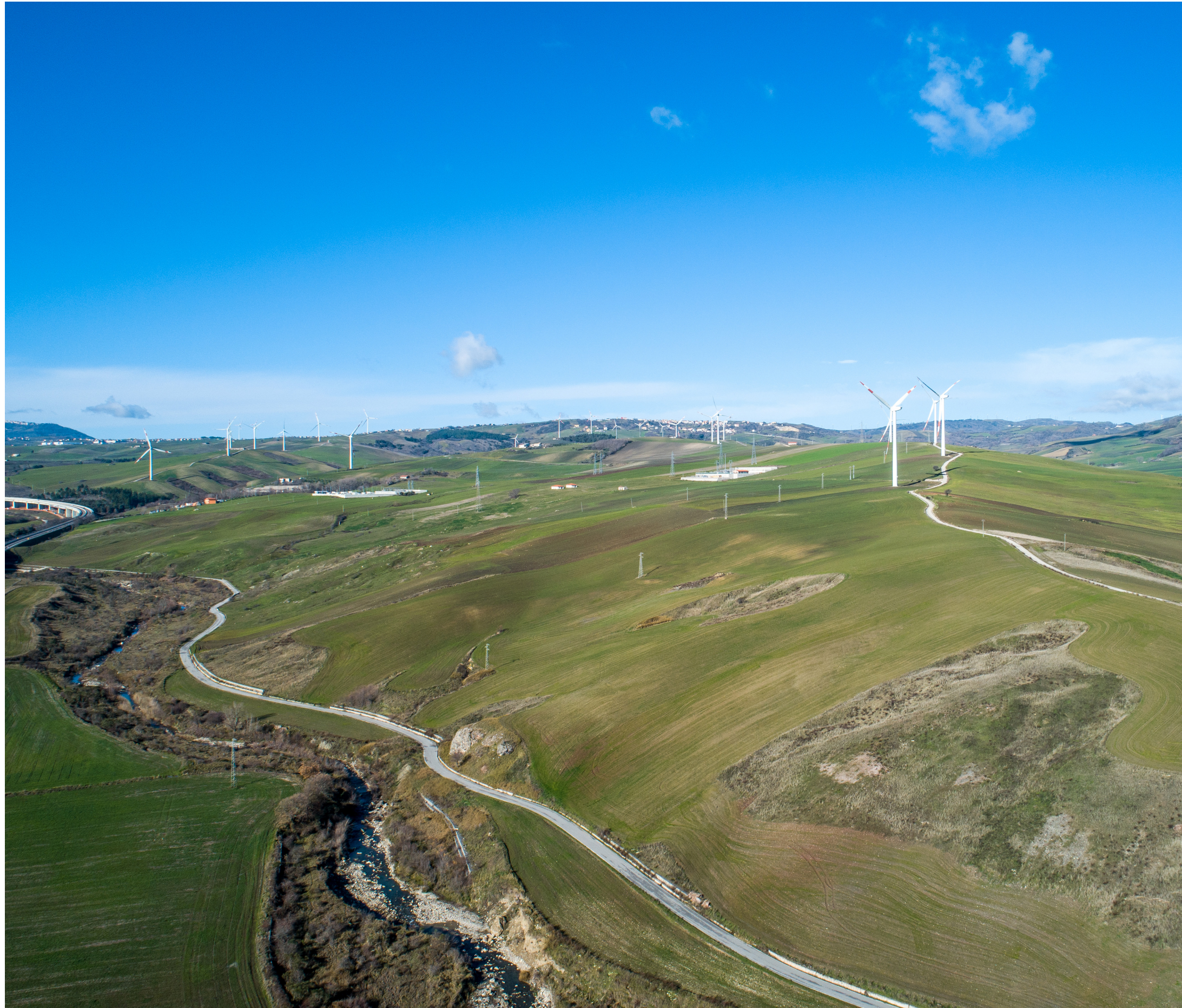
19. Scampitella, impianto eolico
