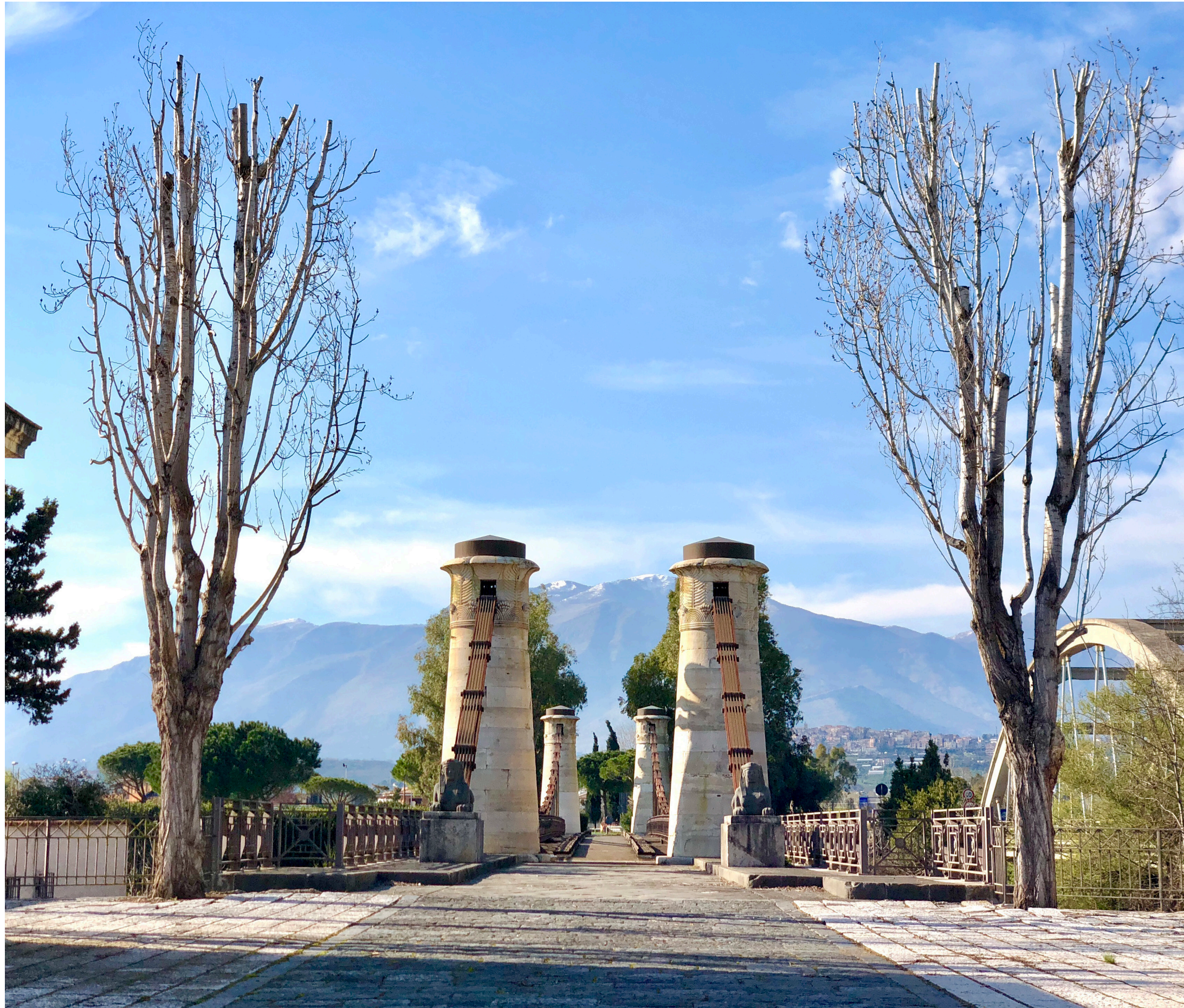
13. Ponte Real Ferdinando sul Garigliano
