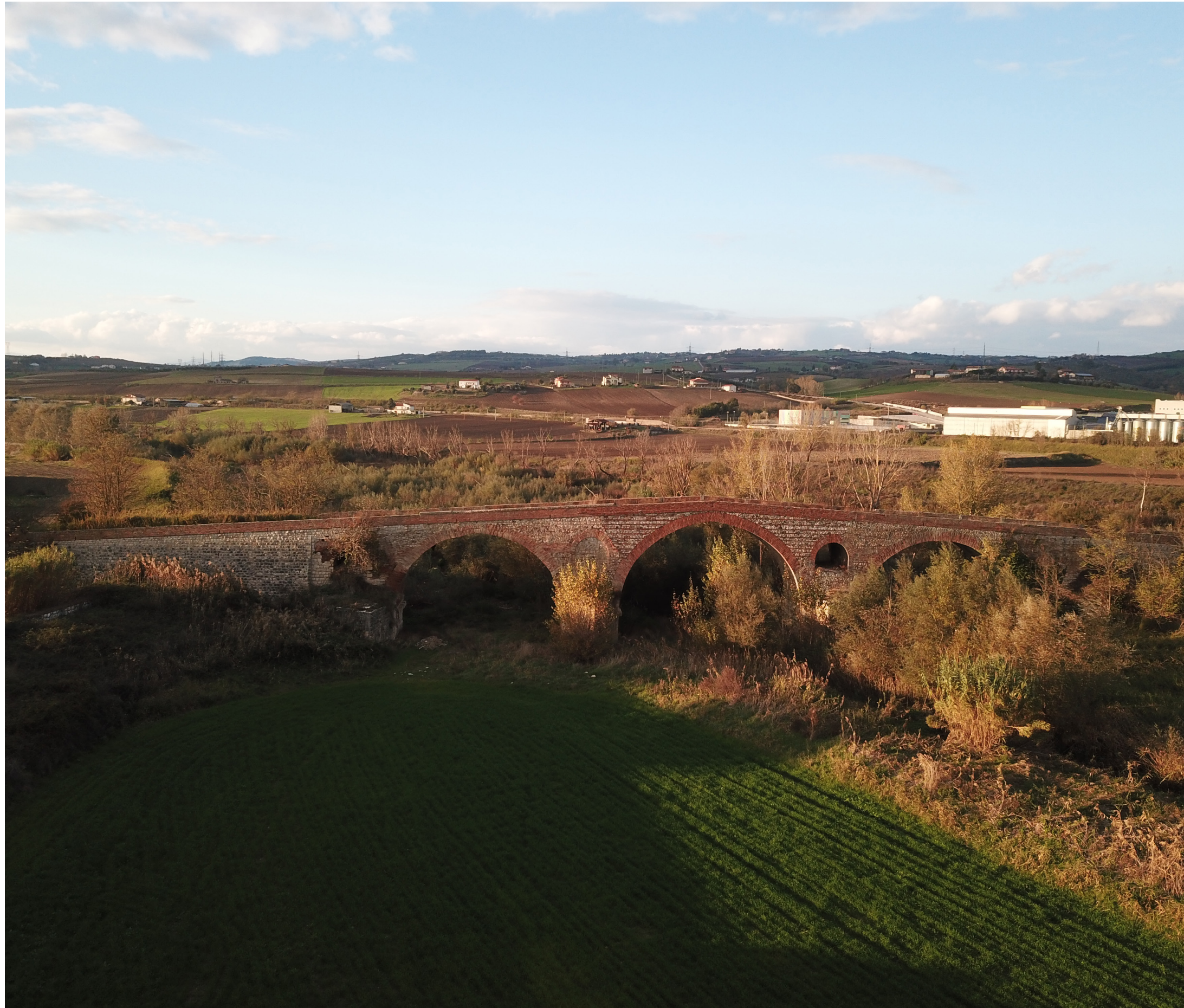
12. Ponte Valentino (foto di R. Pilla)
