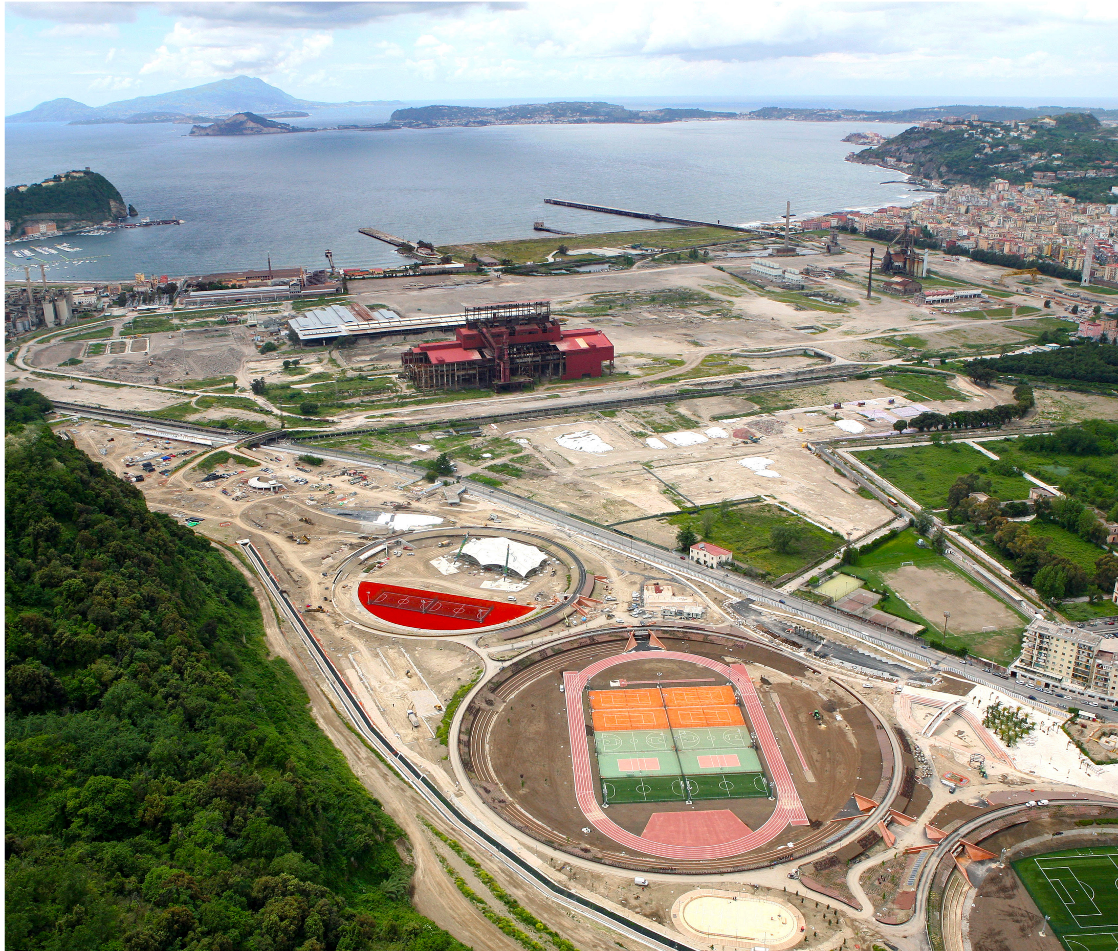
1. Bagnoli, panoramica dell'ex Italsider (foto di R. Battarra)
