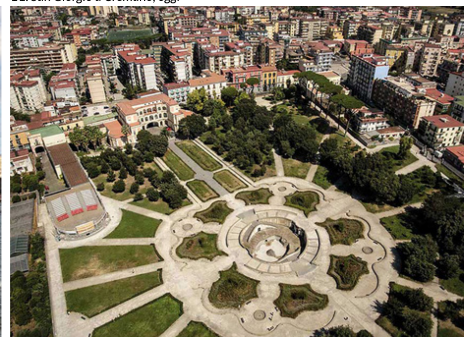
14. Villa Vannucchi a San Giorgio a Cremano, oggi
