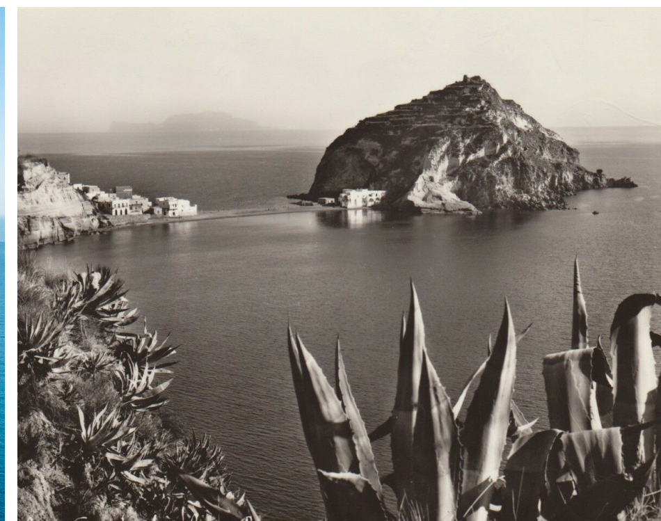
20. Vista della punta di Sant'Angelo, foto storica
