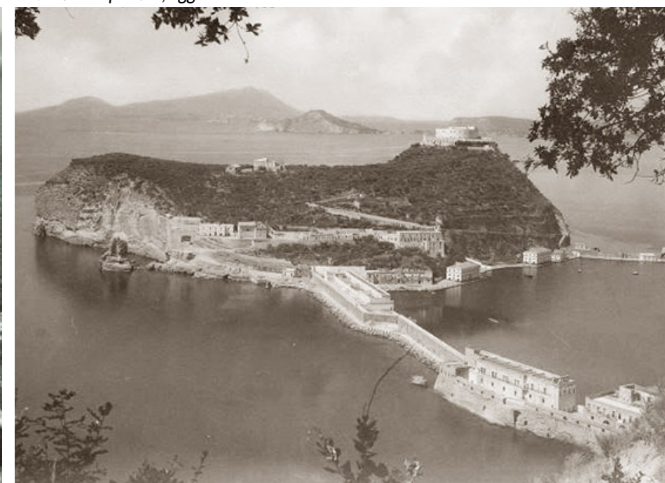
14. Nisida e pontile, foto storica
