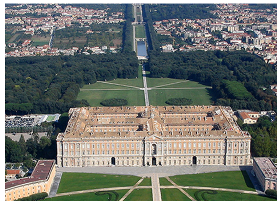
9. Area adiacente alla Reggia di Caserta, oggi
