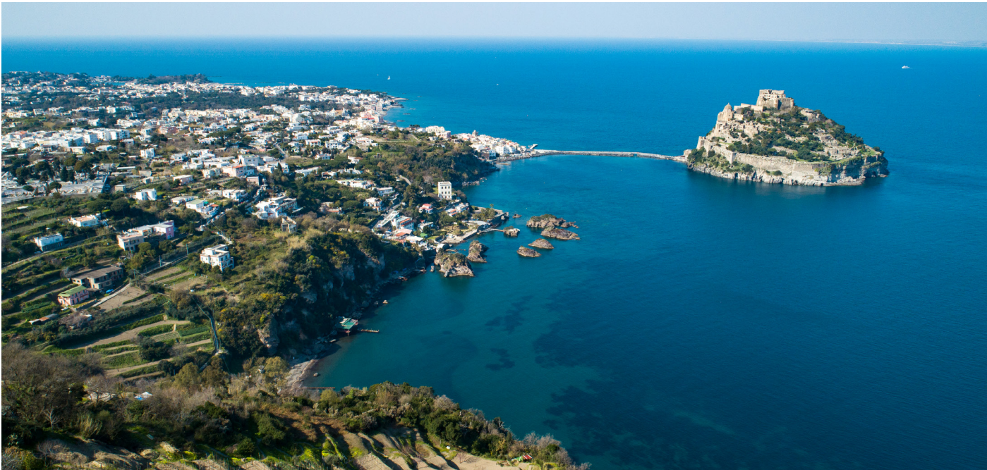
Panoramica sul Castello Aragonese
