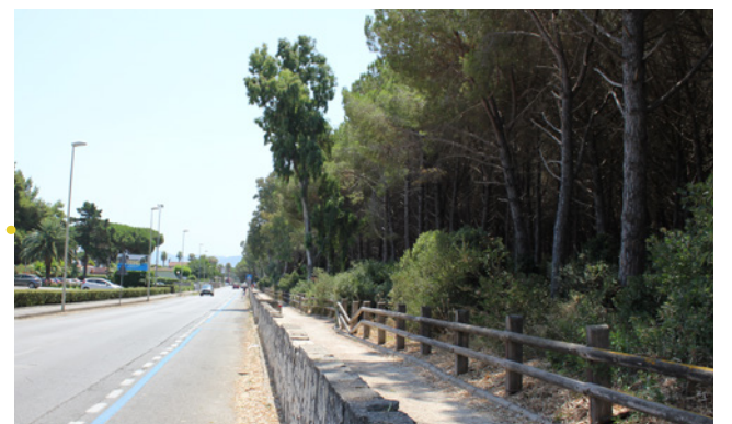
Strada e pista ciclabile in stato di abbandono
