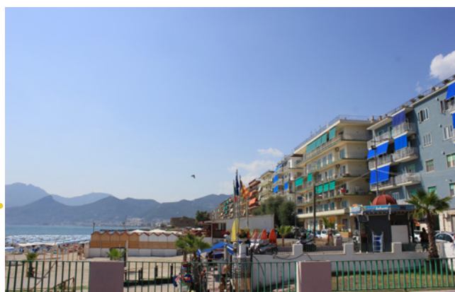
Lidi ed edificato lungo la litoranea
