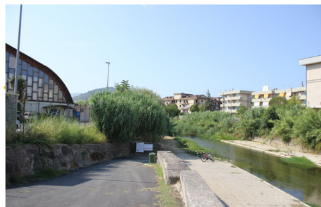
Area parzialmente utilizzata del lungofiume
