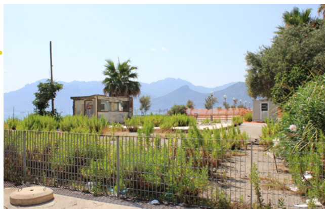
Area lungomare con lavori in corso
