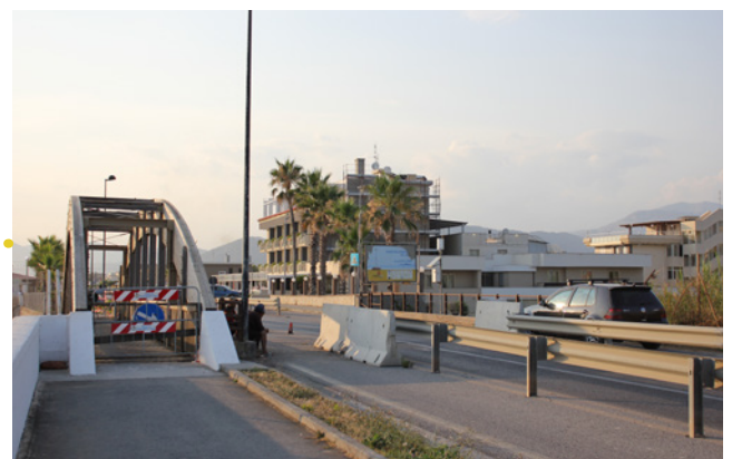
Ponte sul torrente Asa
