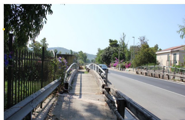
Ponte sul canale e interruzione ciclabile
