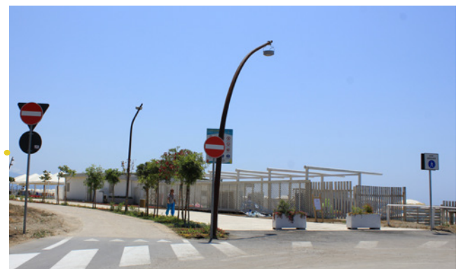
Lungomare pedonale di nuova realizzazione
