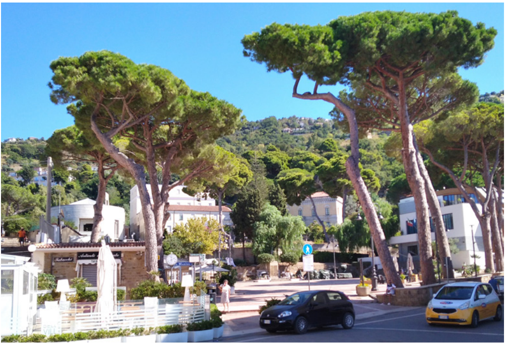
91 Accesso ai sistemi meccanizzati da S.M. di Castellabate: stazione di valle della nuova funivia verso il centro storico. Predisposizione area parcheggio accessibile dalla SP.
