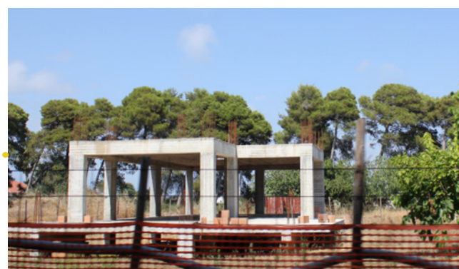
Edificio incompleto da verificare
