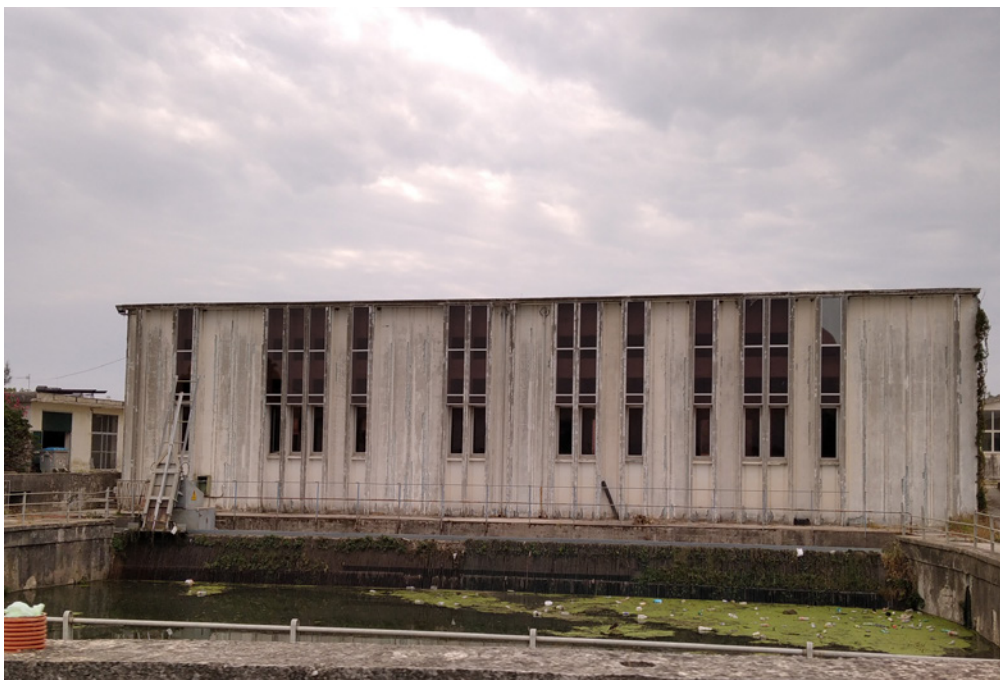
32 Idrovora Aversana: riqualificazione manufatti idraulici a servizio delle reti verdi e blu, canali di bonifica come reti eco-sistemiche
