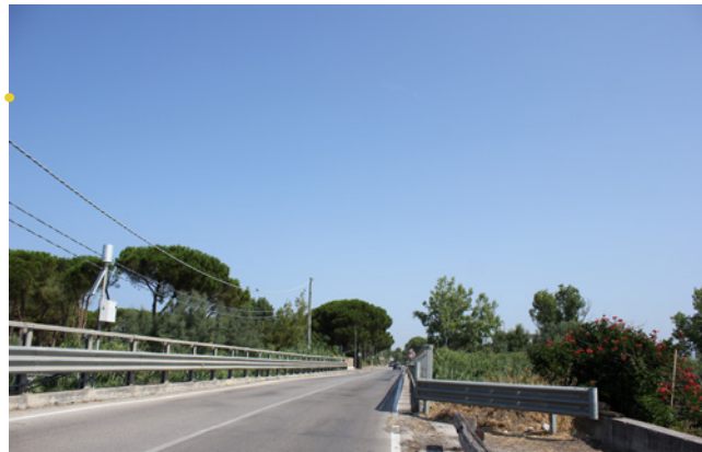
Ponte sul canale - interruzione ciclabile
