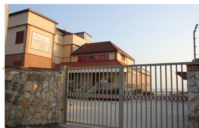
Struttura alberghiera lungo la litoranea
