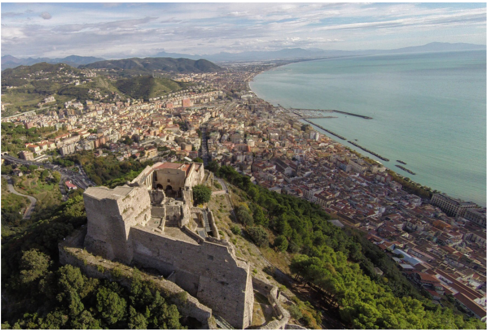
1 Collegamento tra il Castello Arechi e Quartiere Canalone
