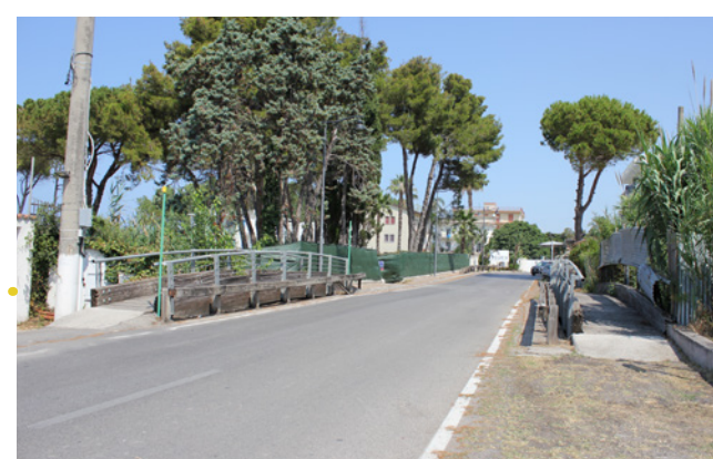
Ponti di attraversamento sulla foce
