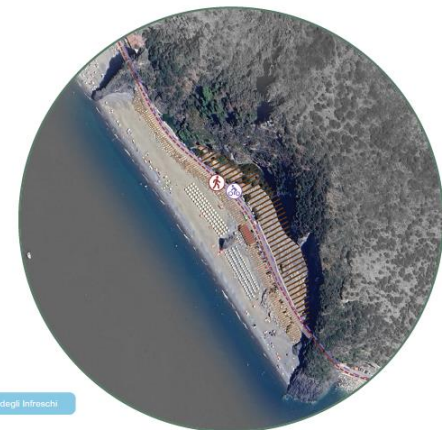
Intervento di difesa costiera sulla SP 562/d - restauro naturalistico
