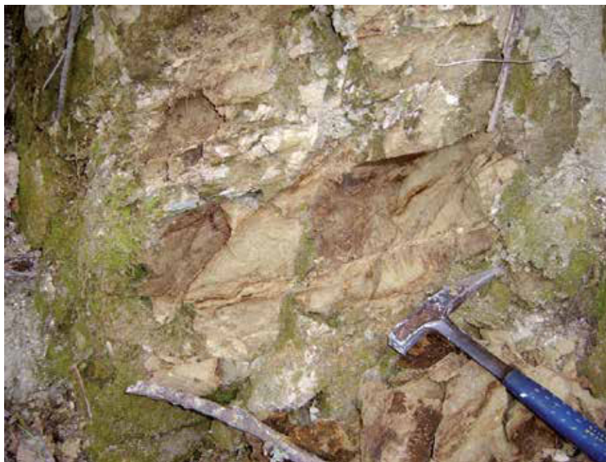
Fig. 46 - unità di Campomanno (CPM). Depositi epiclastici litificati e intensamente fratturati (località via Ombrasco).
