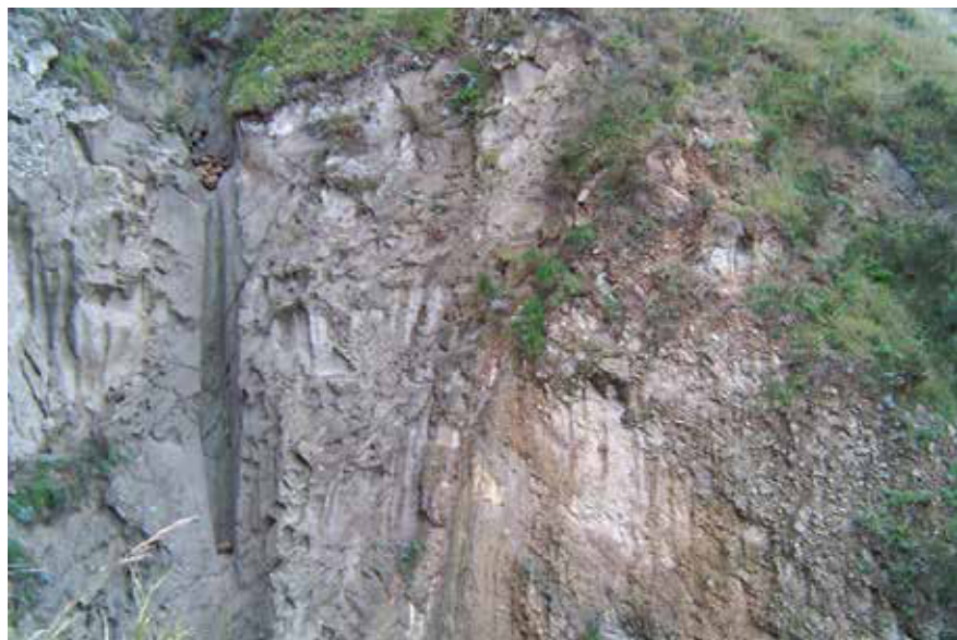
Fig. 141 - Faglia a direzione NO-SE in località Ciglio dove affiora il contatto tra il Tufo Verde del Monte Epomeo Auct. (sinistra) e i tufi di Serrara-Cava Petrella (destra). Questa struttura sub-verticale rappresenta lo svincolo alla struttura sollevata del Monte Epomeo. Si presenta con una geometria curvilinea con una diminuzione dell'angolo di pendenza verso l'alto. Questo tipo di geometria è comune a strutture con forte pendenza prodotte da un movimento prevalentemente verticale in profondità.
