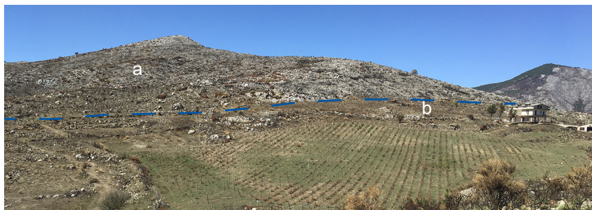
Fig. 46 - Panoramica dell'unità ESL : a) livelli a olistoliti calcarei; b) matrice dell'unità caotica di ESL . Località: sud di Crestegallo.
