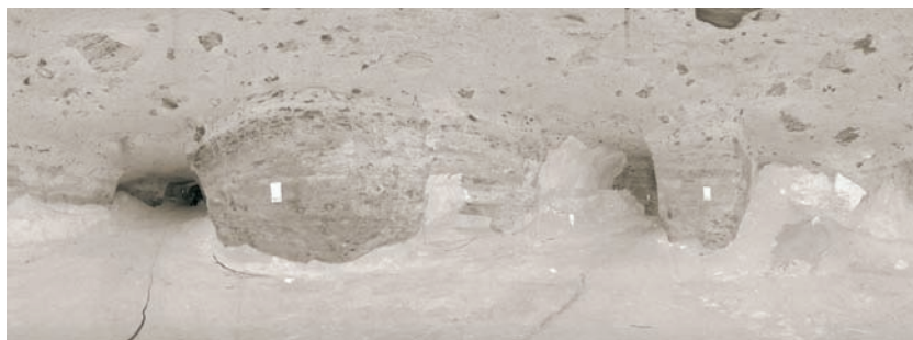
ripresa laser scanner 04
