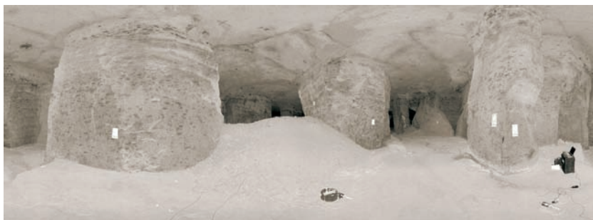
ripresa laser scanner 21
