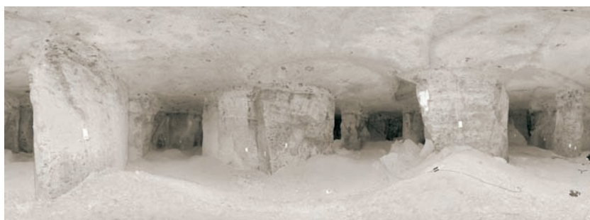
ripresa laser scanner 20
