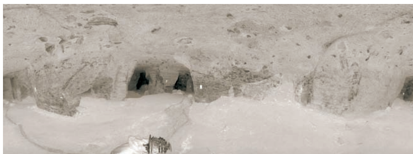
ripresa laser scanner 06
